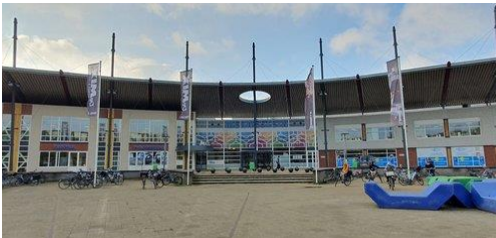
Idræts- og eventcentret Merwestein i Nieuwegein huser blandt andet et af Hollands bedste svømmecentre og bygger på en innovativ model for kommunal facilitetsdrift og lokalt engagement. Foto: Henrik H. Brandt
